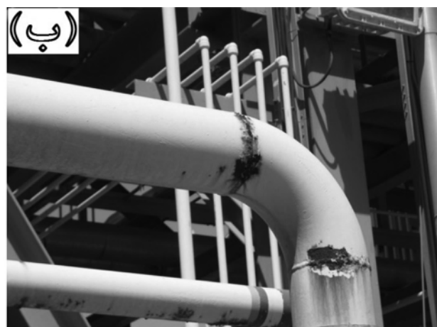
شکل ۱ - تصاویر نمونه از وضعیت سامانه پوششی در یک پالایشگاه گاز، (الف) پوشش مناسب، (ب) پوشش تخریب شده در ناحیه جوش.
