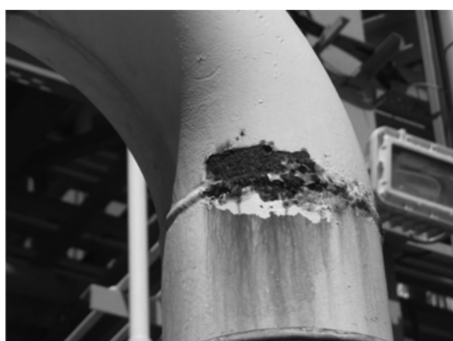
شکل ۱ - تصاویر نمونه از وضعیت سامانه پوششی در یک پالایشگاه گاز، (الف) پوشش مناسب، (ب) پوشش تخریب شده در ناحیه جوش.
