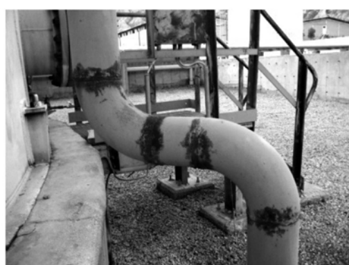
شکل ۱ - تصاویر نمونه از وضعیت سامانه پوششی در یک پالایشگاه گاز، (الف) پوشش مناسب، (ب) پوشش تخریب شده در ناحیه جوش.
