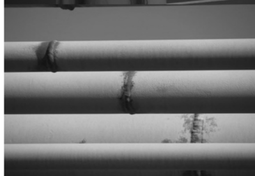
شکل ۲ - نمونه‌هایی از تخریب پوشش در نواحی جوش لوله‌ها و ساختار پالایشگاه‌های گاز.
