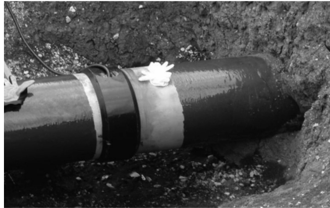
شکل ۹ - نصب حلقه دائمی GW بر روی خط لوله مدفون
