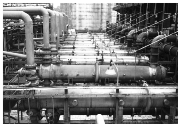
شکل ۵ - حفاظت آندی مبدل‌های حرارتی ساخته شده از فولاد زنگ‌نزن برای خنک کردن سولفوریک اسید ۹۸-۹۳٪
