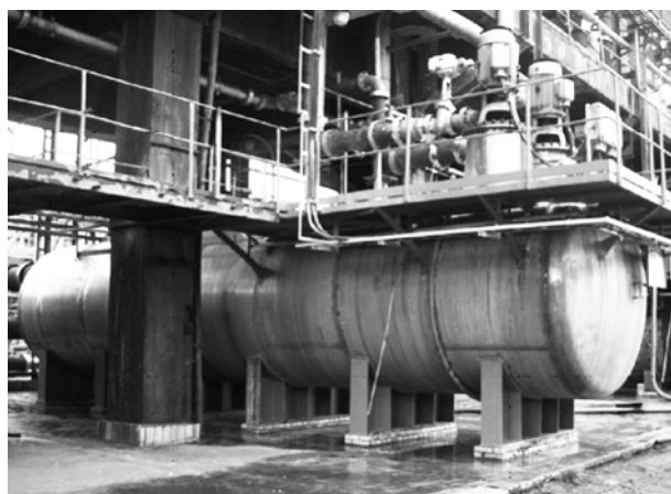
شکل ۴ - مخزن حفاظت آندی شده برای ذخیره سولفوریک اسید خالص ۹۹ - ۹۴ درصد در دماهای بیش از ۴۰ درجه سلسیوس
