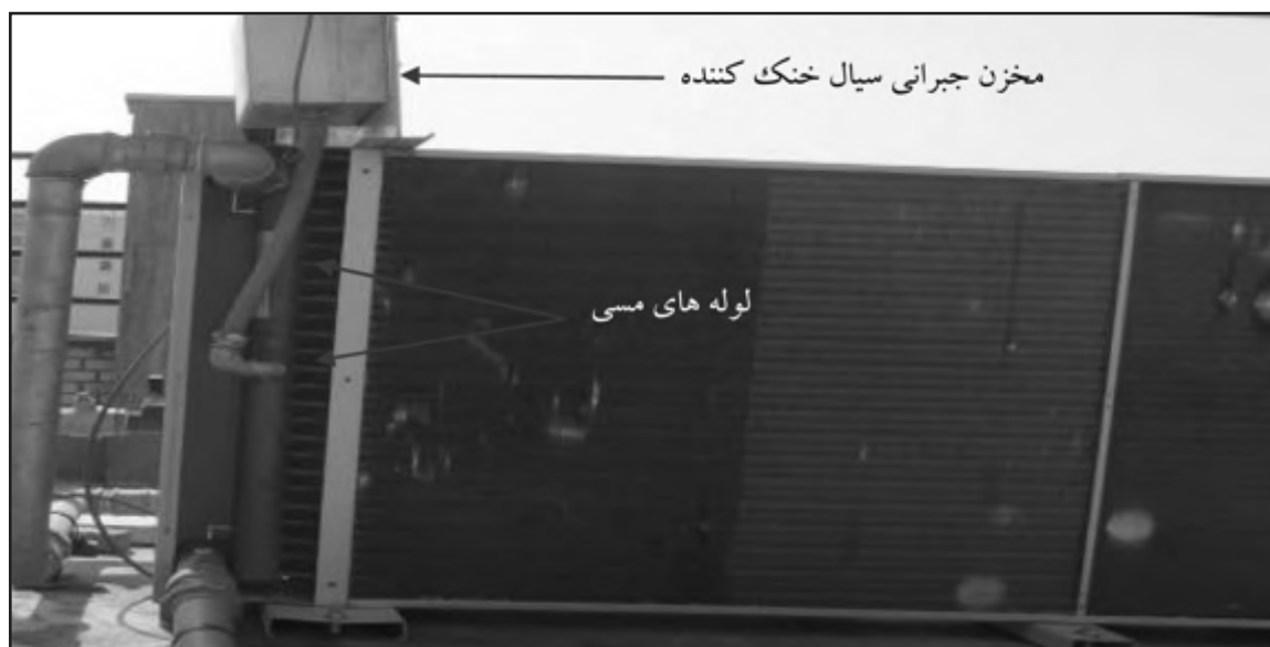
شکل ۶- تصویر کولر هوایی مورد استفاده با لوله‌های مسی جهت خنک کردن سیال گرم شده برگشتی و مخزن جبرانی سیال خنک کننده.
