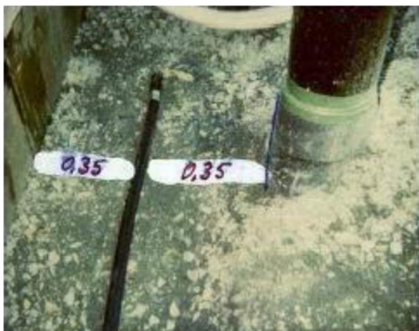
شکل ۱۱ - آند کابلی به منظور حذف پیل‌های موضعی، بین خط لوله و فنداسیون نصب می‌شود.
