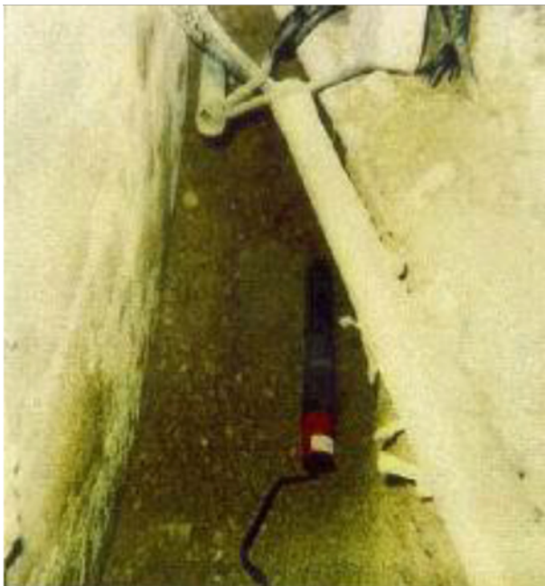
شکل ۱۰ - آند چدنی به منظور حذف پیل‌های موضعی، بین خط لوله و فنداسیون نصب می‌شود.
